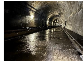
鍋立山トンネル
