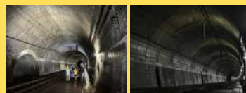
鍋立山トンネル
